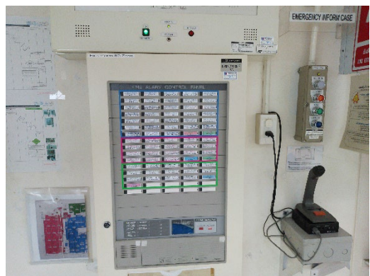
ภาพที่ 2.2-21 ระบบสัญญาณเตือนภัย และอุปกรณ์ดับเพลิง
