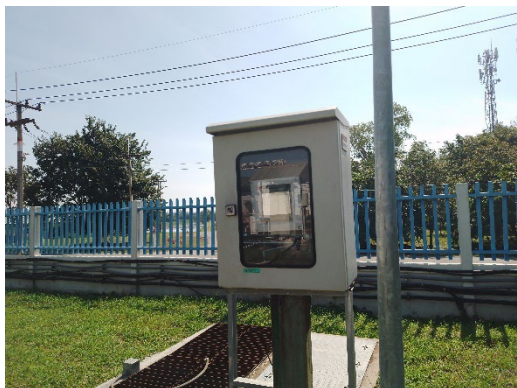
ภาพที่ 2.2-7 ระบบ pH Online ที่บ่อ (Inspection pit)
