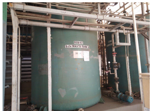
ภาพที่ 2.2-9 (ต่อ) ถังเก็บน้ำเสียปนเปื้อนสารเคมี
