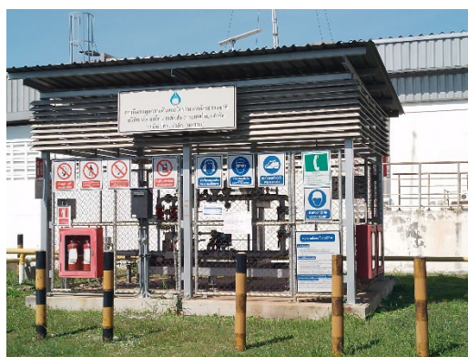
ภาพที่ 2.2-30 สถานีควบคุมและวัดปริมาณก๊าซ
