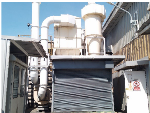
ภาพที่ 2.2-1 ระบบ Dust Collector Scale Rod
