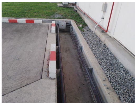
ภาพที่ 2.2-13 รางระบายน้ำฝนภายในพื้นที่โครงการ
