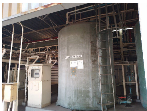
ภาพที่ 2.2-9 ถังเก็บน้ำเสียปนเปื้อนสารเคมี
