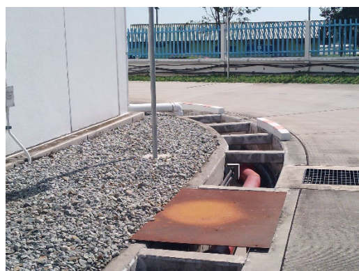
ภาพที่ 2.2-13 รางระบายน้ำฝนภายในพื้นที่โครงการ
